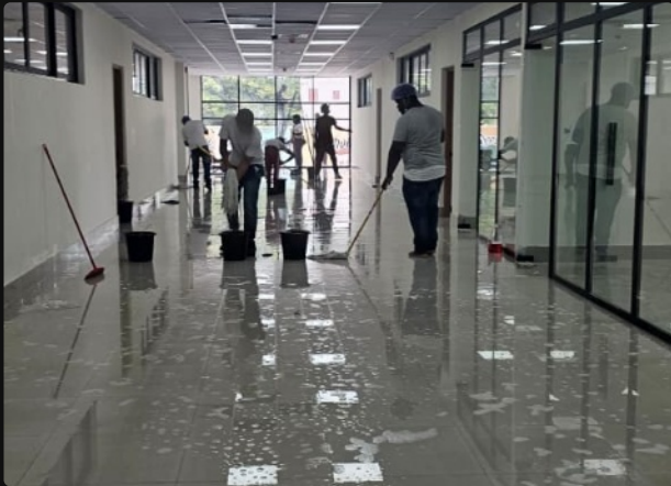
Personal laborando en la limpieza y lavado del piso.
